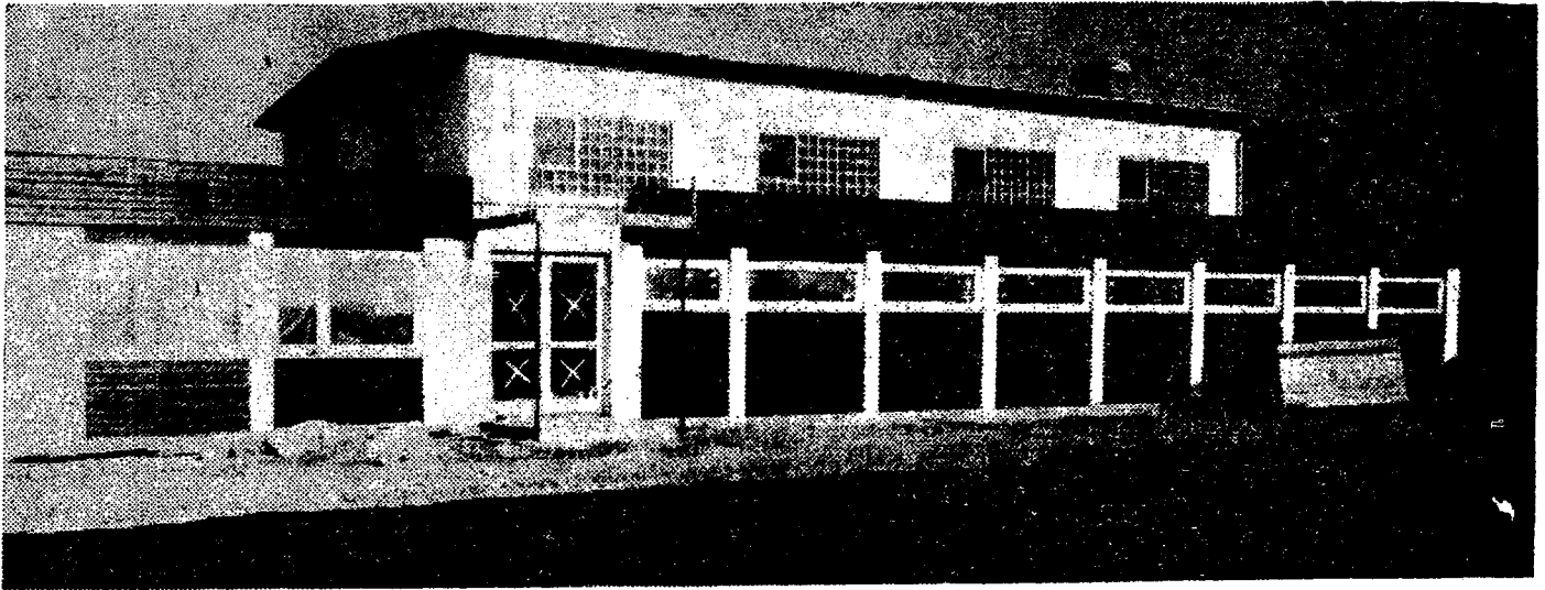
EINE MODERNE TURNHALLE BAUTEN MITGLIEDER DES SPORTVEREINS ASCHOLDING in Eigenleistung. Die Halle wird dem Schulverband Egling zur Benützung zur Verfügung gestellt. (Nahr, 2)
